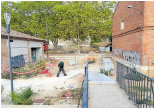
Un peatón camina junto al acceso, todavía en obras, a las viviendas de los números 18 al 26 desde el puentecillo del Canal de Castilla.
