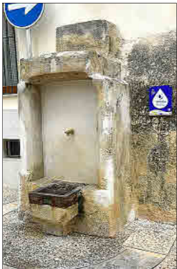
Los ciudadanos tienen nuevos puntos de acceso de agua potable.
