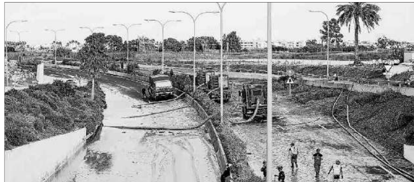
Se trabaja en un proyecto para resolver las inundaciones en la carretera del aeropuerto. Fotos: A. ESCANDÓN
