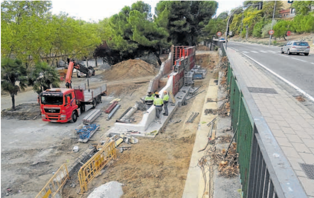
Trabajos en el nuevo acceso peatonal que unirá los jardines de la calle Canal con la cuesta de la Maruquesa por la carretera de Fuensaldaña. FOTOS DE J. S.
