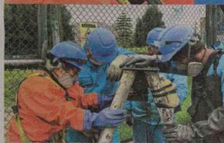
Luz Dary, junto a la cuadrilla de limpieza del Acueducto, trabaja a diario para sacar desechos de las cañerías.
